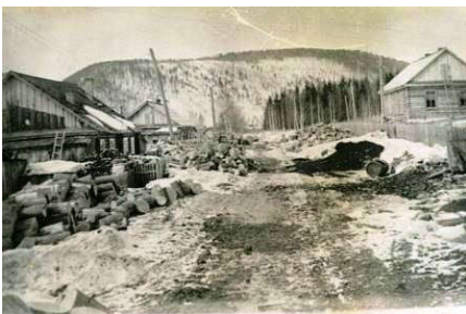
Строительство домов 1962г
